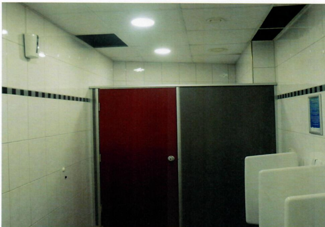
Foto 87_Sanitär 13: WC – Bereiche
